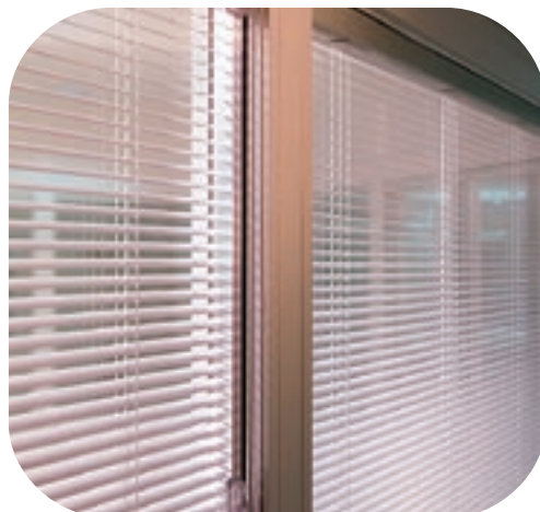
Centre pour enfants de la clinique universitaire, Mannheim (D) : Cloison réalisée avec Pilkington Pyrostop™ , vitrage isolant de protection contre l'incendie avec store vénitien intégré permettant l'occultation variable pour conserver l'intimité des patients et la surveillance par le personnel de garde.
