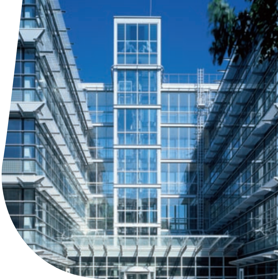
Immeuble de bureaux Baseler Straße, Berlin (D) : Application extérieure en façade de Pilkington Pyrostop™ pour une protection EI (coupe-feu) 90 minutes.
